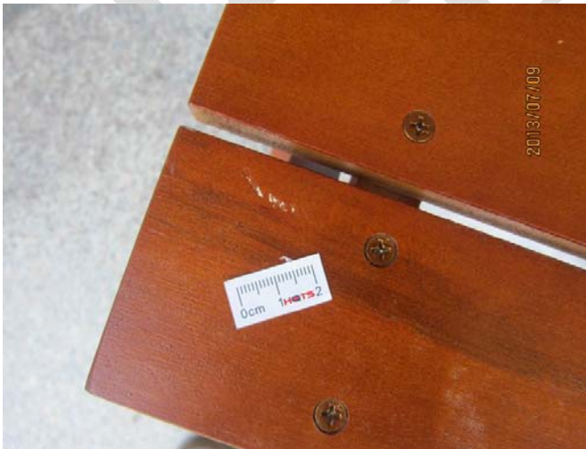
凹痕 + 漆面脱落
