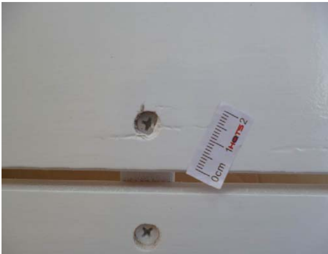
钻孔不良 + 凹痕 + 胶水痕
