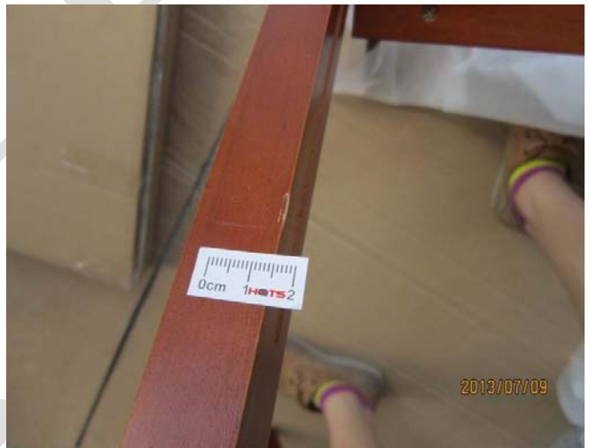
凹痕 + 漆面脱落
